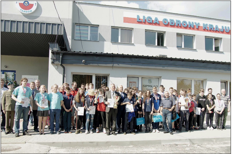
Ośrodek LOK w Tarnowie po modernizacji
