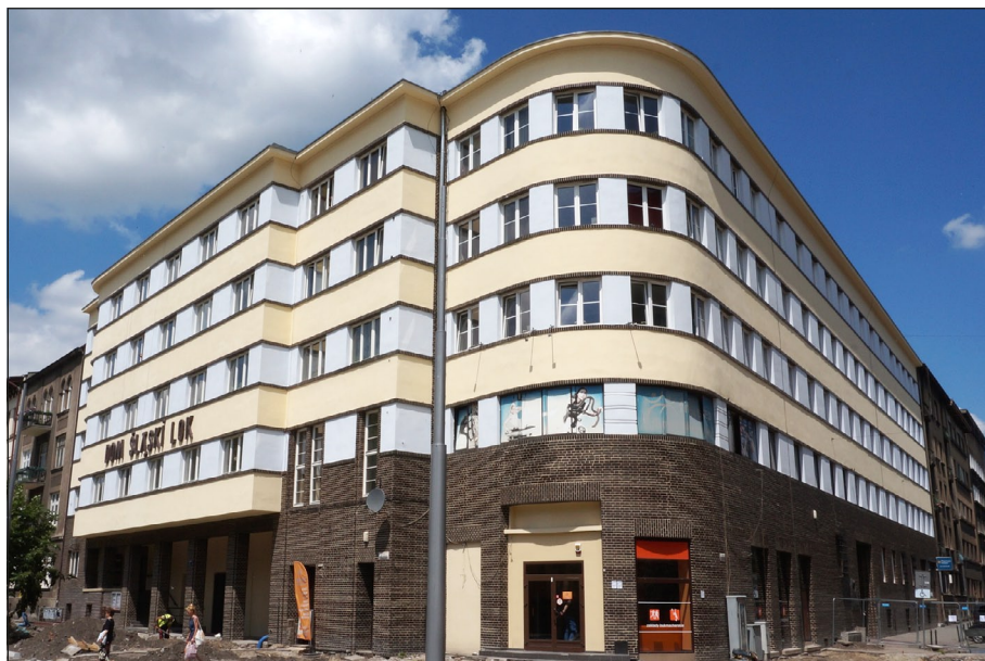
Siedziba Zarządu Wojewódzkiego LOK w Krakowie po modernizacji
