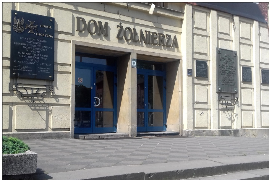
Siedziba Zarządu Wojewódzkiego LOK w Poznaniu po modernizacji
