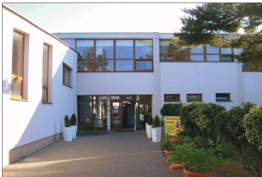
Wyremontowany ośrodek Zachodniopomorskiej LOK
